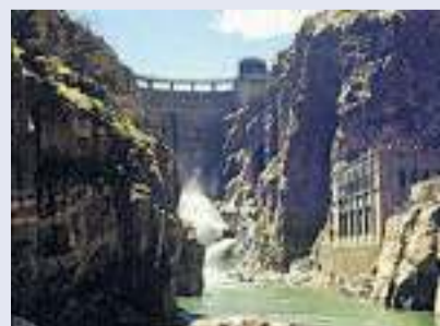
Der Buffalo Bill Dam vom Shoshone Canyon aus gesehen. Bild: pd
